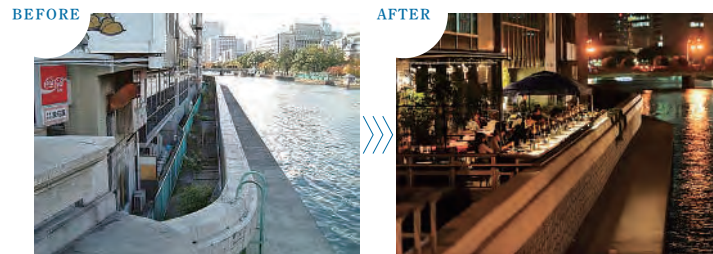
土佐堀川に面するビルは、これまでは写真左のように川に背を向けていたが、2009年に任意地域団地で占用許可を受け(日本初)、川床常設化(こちらも日本初)を実現。川面を感じながら飲食が楽しめる空間「北浜テラス」として生まれ変わった
