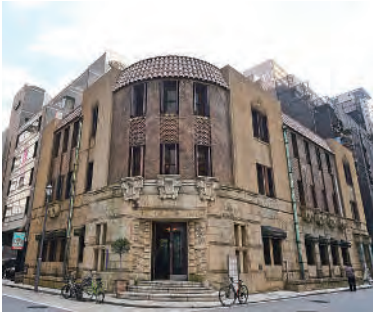
1927年築の芝川ビル。チョコレートショップや眼鏡店などのテナントが入る。最上階に戦後の増築部分を撤去して復元された「芝川ビル モダンテラス」はイベントにも活用されている
