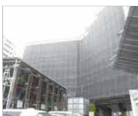
大規模修繕中のマンション。数カ月間は、シートで覆われた状態になります。
